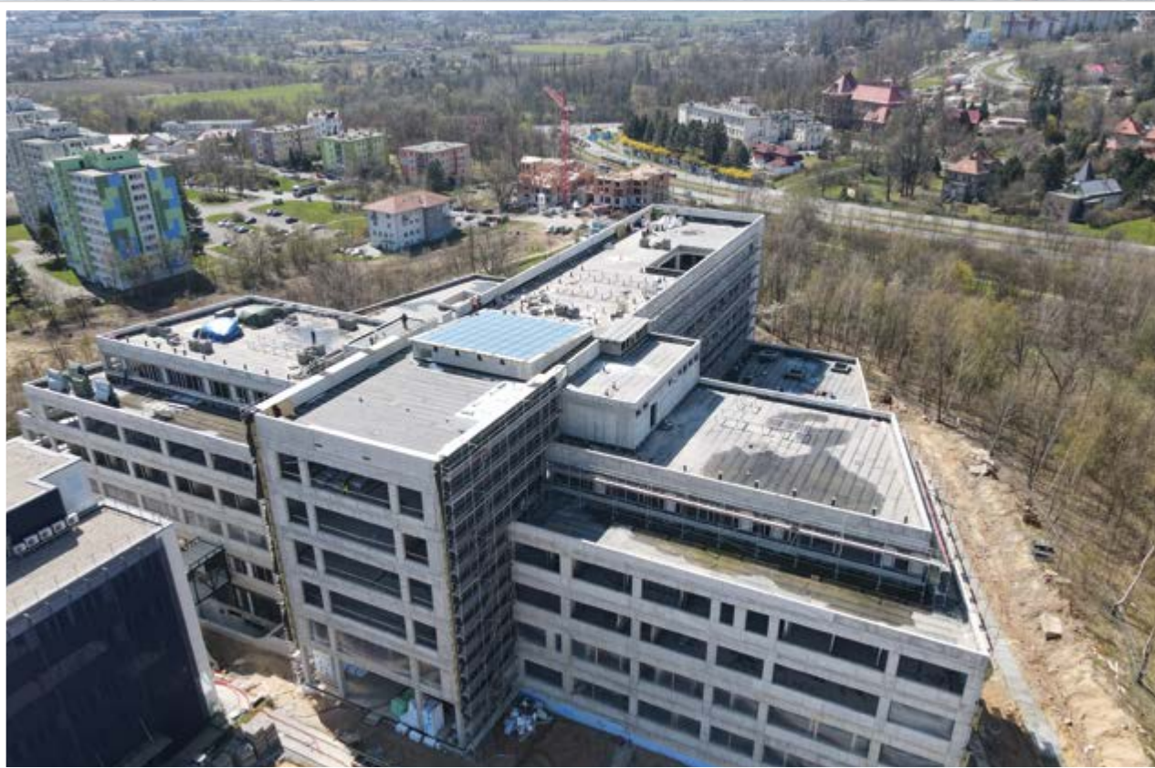
Stavba v dubnu 2021.
