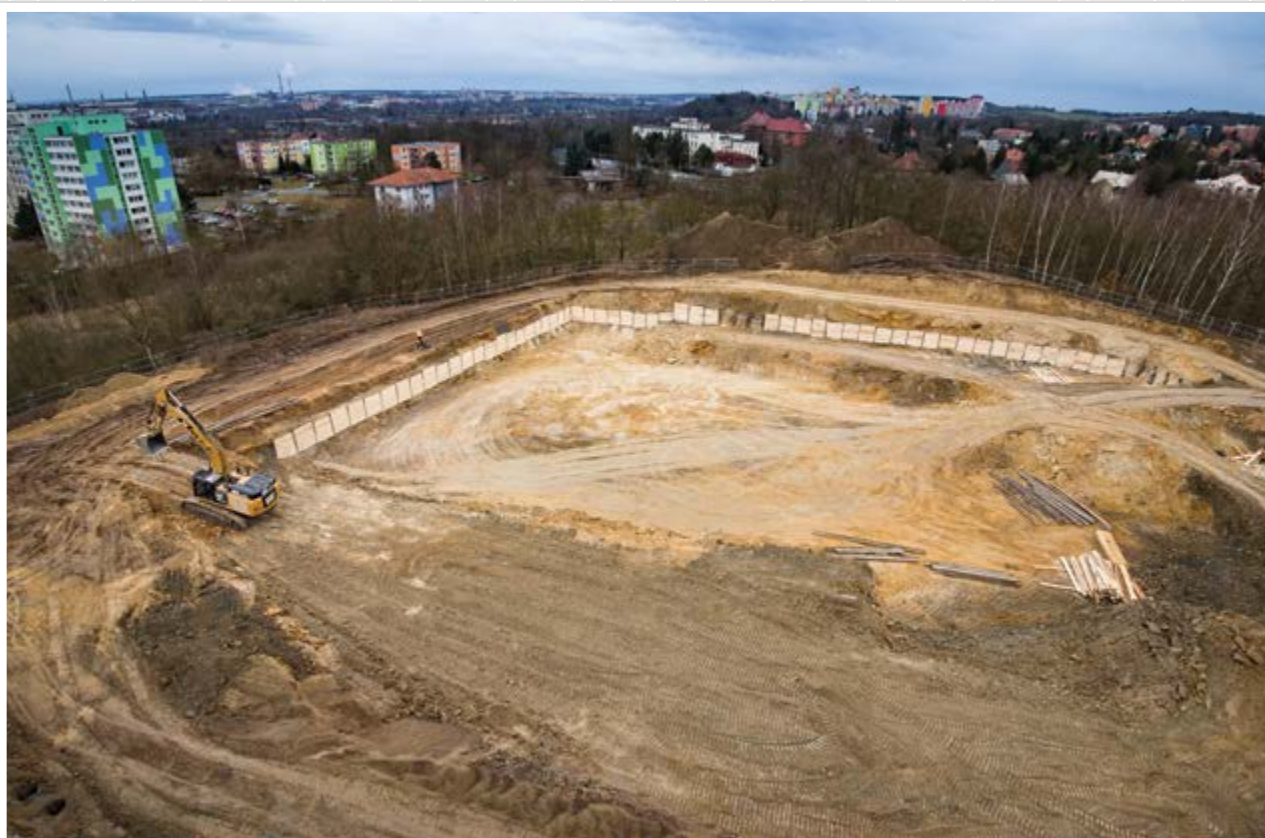
Zahájení 2. etapy výstavby kampusu LFP.
